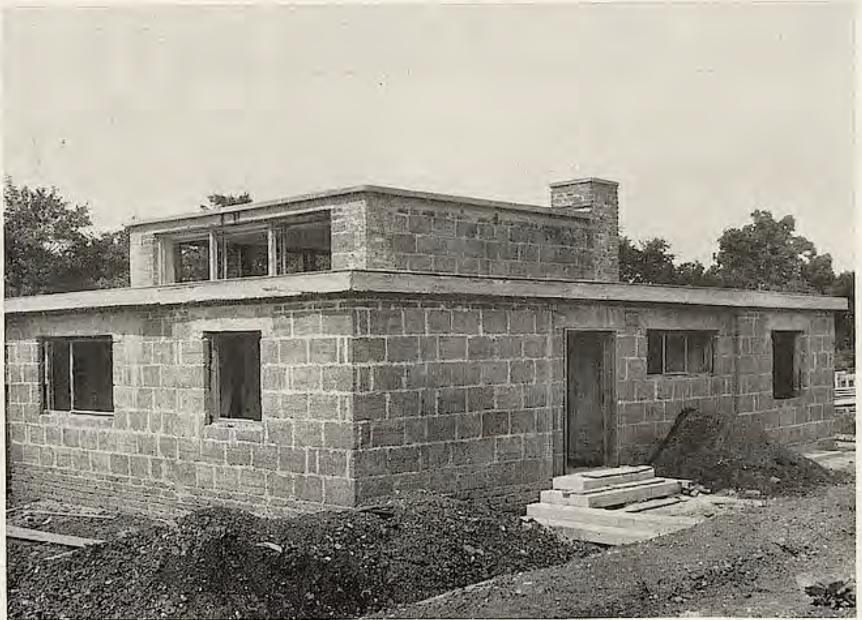
ROHBAUAUFNAHME: WANDAUFBAU IN JURKOPLATTEN
