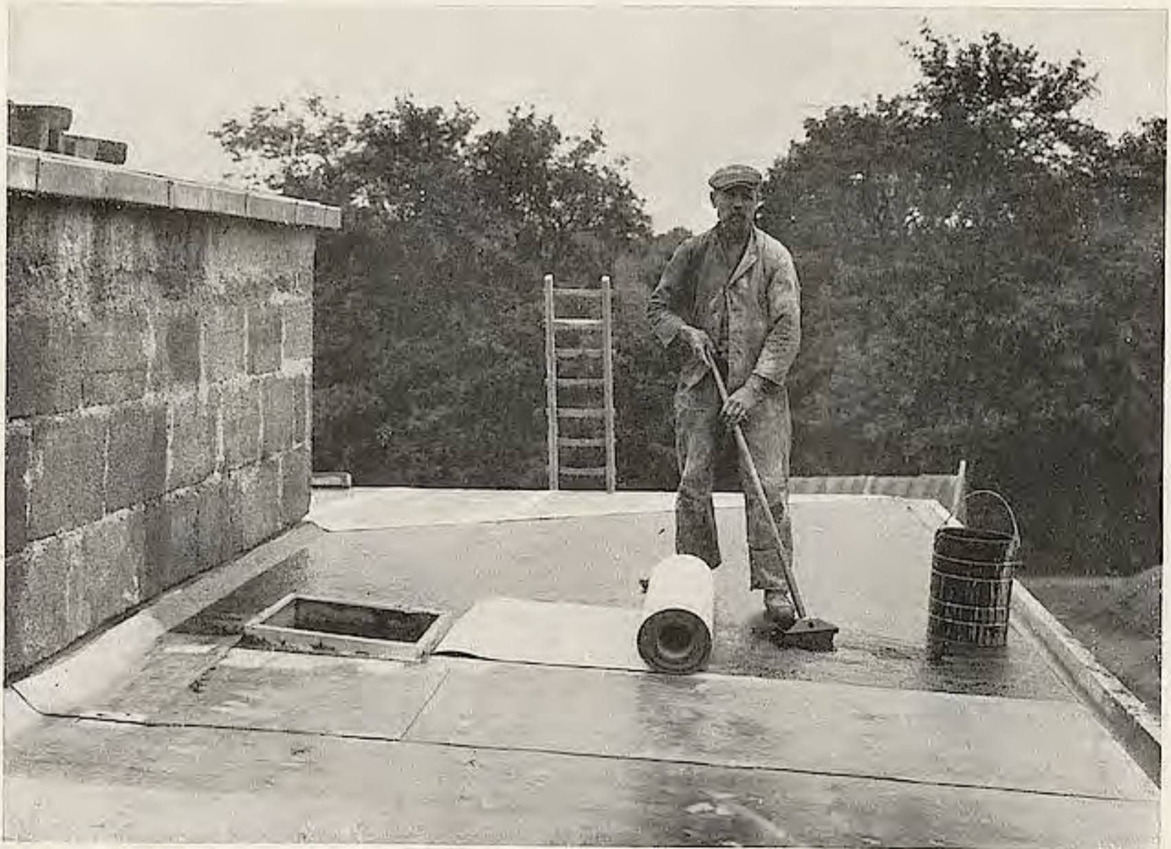
AUFBRINGEN DER RUBEROIDEINDECKUNG AUF DAS DACH
