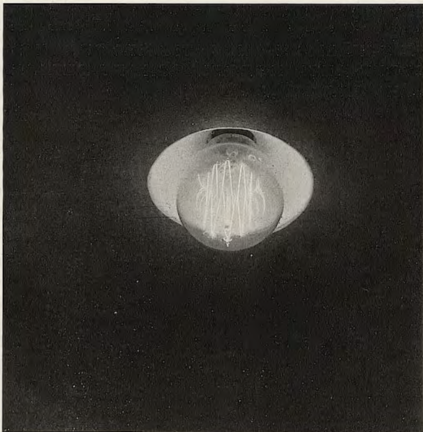
BELEUCHTUNGSKÖRPER IM GASTZIMMER UND IN DER TOILETTE PORZELLANARMATUR IN DER DECKE BÜNDIGLIEGEND J. KARL, ELEKTROTECHNISCHE FABRIK, OBERWEIMAR
