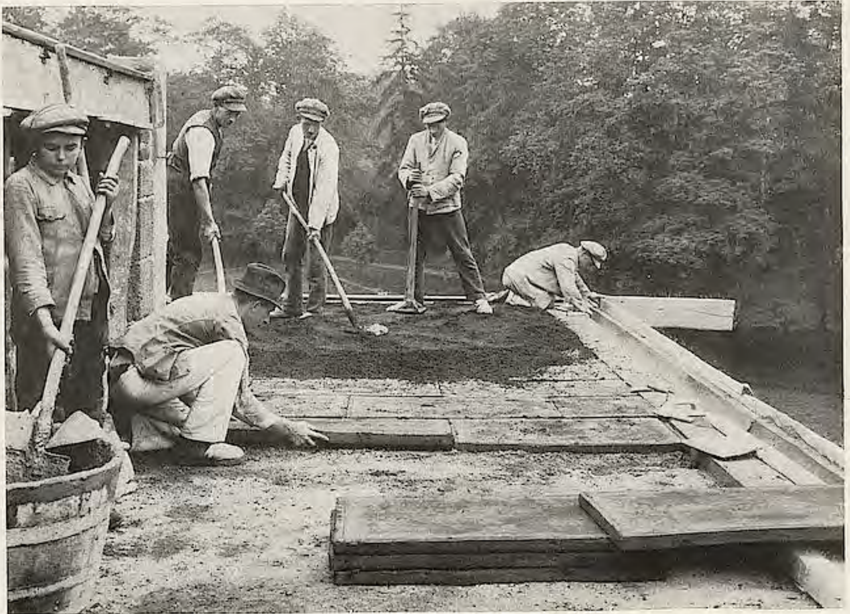
AUFBRINGUNG DER TORFOLEUMTAFELN AUF DIE DACHFLÄCHEN
