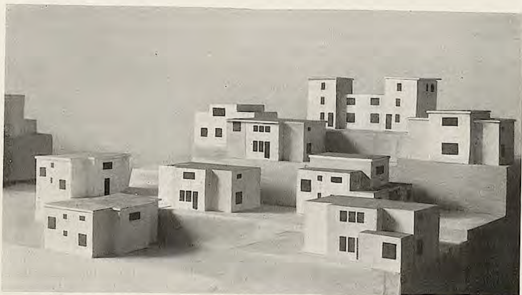
MODELLE ZU SERIENHÄUSERN. VARIABILITÄT DESSELBEN GRUNDTYPS DURCH WECHSELWEISEN AN- UND AUFBAU SICH WIEDERHOLENDER RAUMZELLEN
