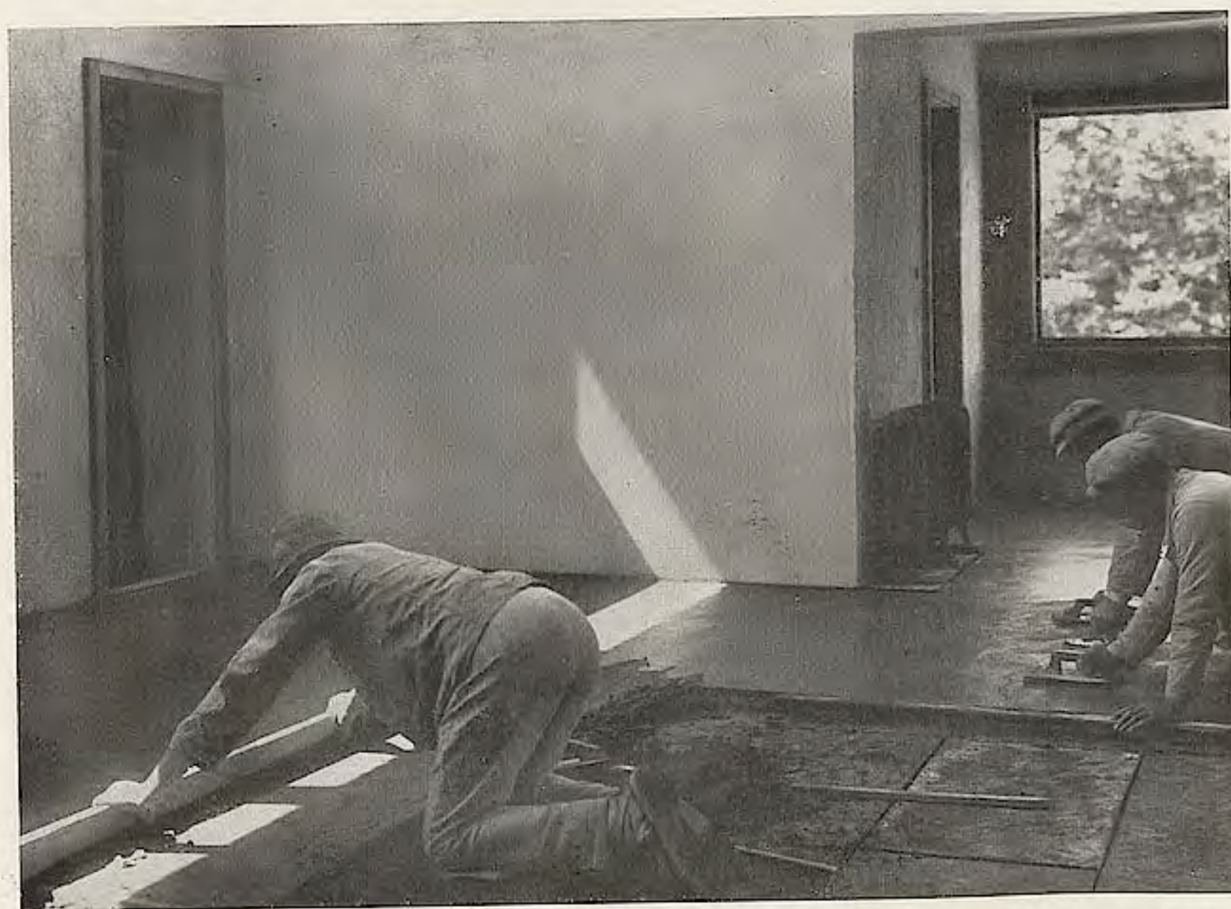
TORFOLEUMISOLIERUNG DES FUSSBODENS UNTER DEM ESTRICH
