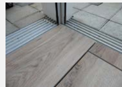
Untere Führung bodenbündig
