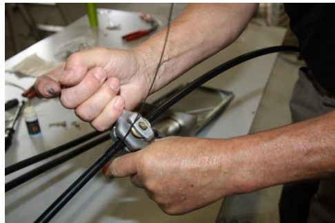
Halkaise vaippa teräslankojen urista käyttäen ST-OCS -vaippakuorijaa.
