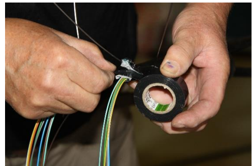
Käännä Flex-kuituputket toista vaipanpuoliskoa vasten ja suojaa ne vaipan päässä eristysnauhalla.
