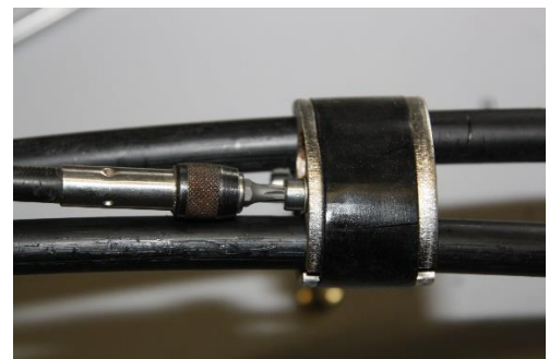
Ruuvaa läpivientikappaleen metalliosat kiinni toisiinsa mutta älä kiristä vielä tässä vaiheessa.
