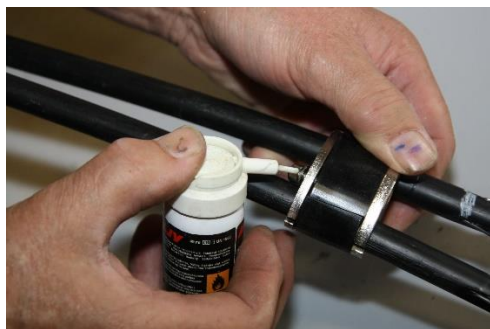
Rasvaa läpivientikappaleen kiristysruuvit ennen niiden kiristystä.
