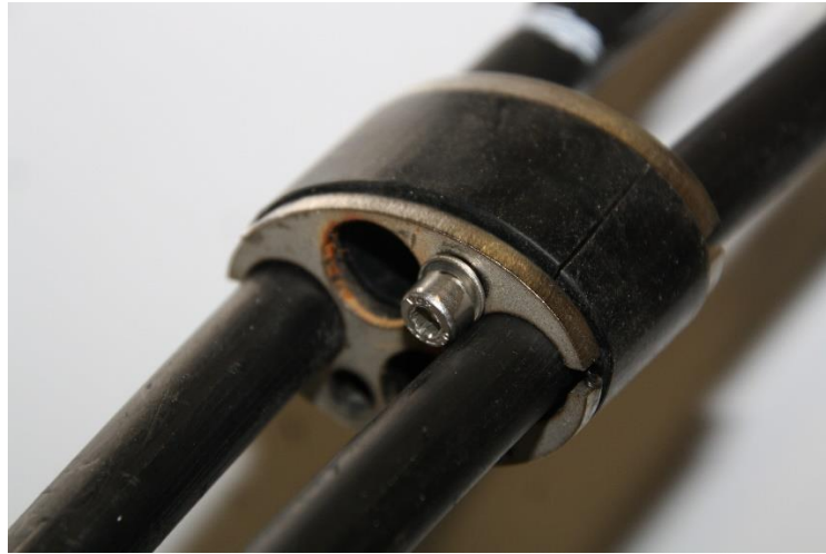
Mekaaninen läpivientikappale asennettuna.
