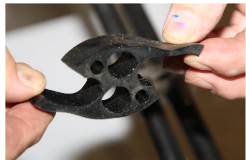
Halkaise läpivientikappaleen kumiosassa käytettävät läpivientiaukot mattopuukolla.
