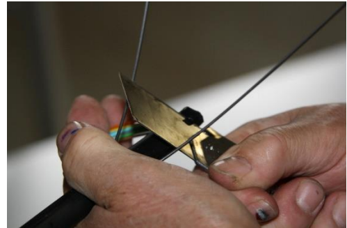
Ohenna hieman kaapelin päitä. Näin ne menevät helpommin läpivientikappaleiden läpi mutta tämä on tarpeen myös maadoitusliittimien asennuksessa.
