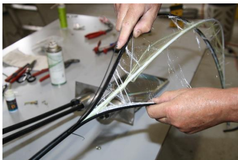
Vedä vaipan puoliskot erilleen ja katkaise ne noin 3 cm:n pituisiksi. Katkaise vaipan alla olevat vahvikkeet. Paina tämän jälkeen vaipan puoliskot yhteen.
