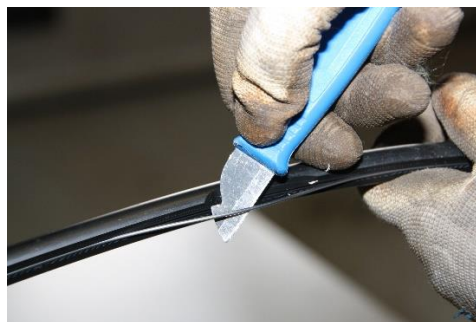
Kaiva teräslangat esille.
