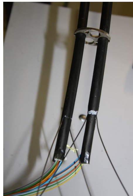
Kaapelin päät vedettynä ulomman läpivientikappaleen läpi.
