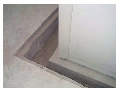
Dettaglio Scavo Excavation example
