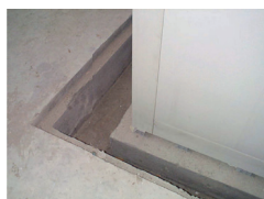
Dettaglio Scavo Excavation example
