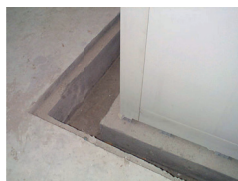
Dettaglio Scavo Excavation example
