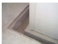
Dettaglio Scavo Excavation example
