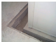
Dettaglio Scavo Excavation example
