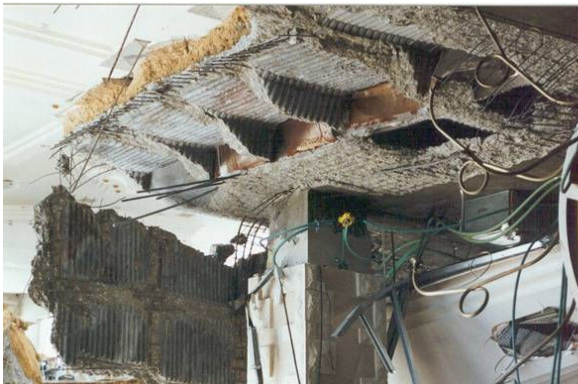
תמונה 2 : כשל בגזירה בצלעות בסמוך לעמוד
